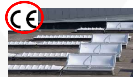
Evacuatori naturali di fumo e calore
