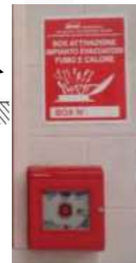
Sistema di comando e attivazione
