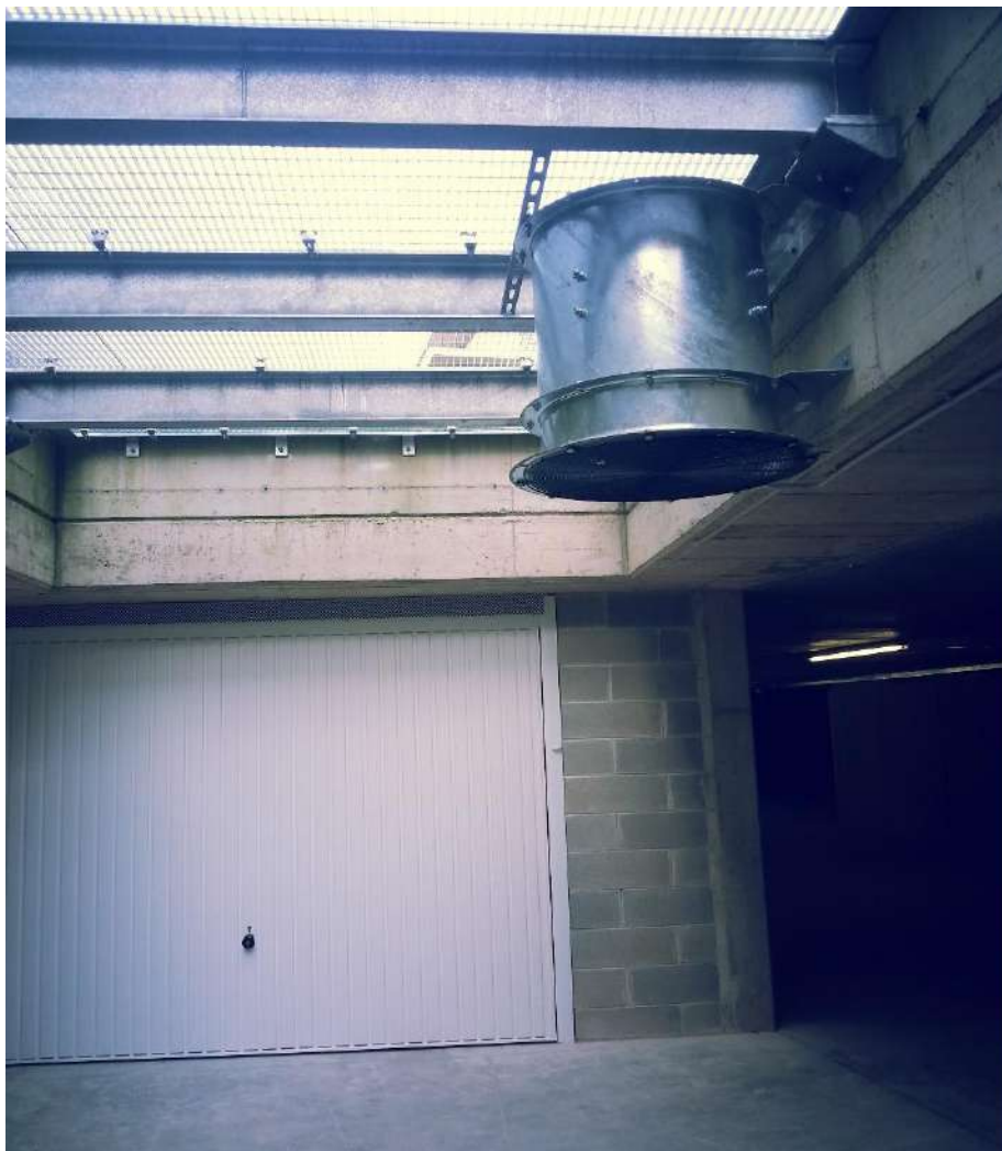
Impianto Jet Fan per Autorimessa condominiale realizzazione anno 2015, Cantù (CO).
